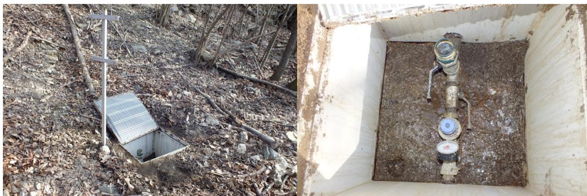
**Figura 8.** Testa antincendio presente lungo la condotta esistente sul territorio del Comune di Mompantero, dalla quale è prevista una derivazione interrata a servizio della porzione occidentale del Settore 1 di pascolamento posta alle altitudini superiori.
