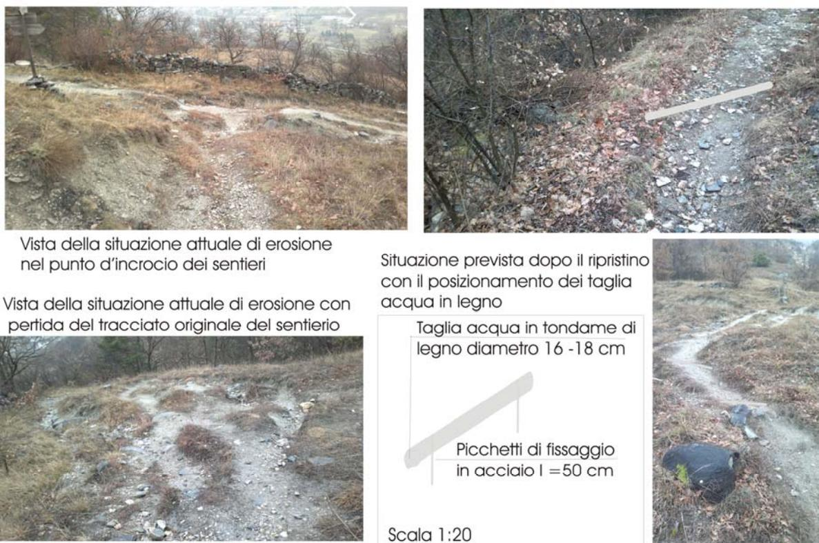
**Figura 11.** Interventi di sistemazione del tratto di sentiero in erosione presso "Comba Ravera" con tondame in legno (Bussoleno).
