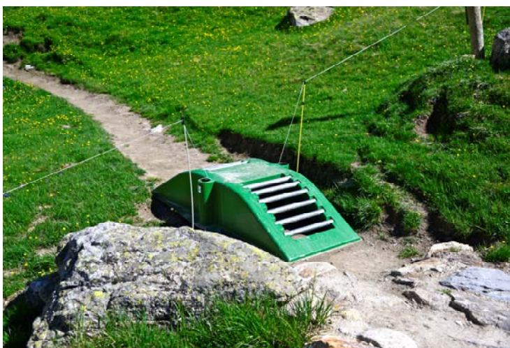
Figura 7. Esempio di cancello canadese su recinzione mobile elettrificata adatto a percorsi escursionistici e cicloturistici. Questo tipo di cancello è atto al contenimento sia di bovini, sia di ovini.
