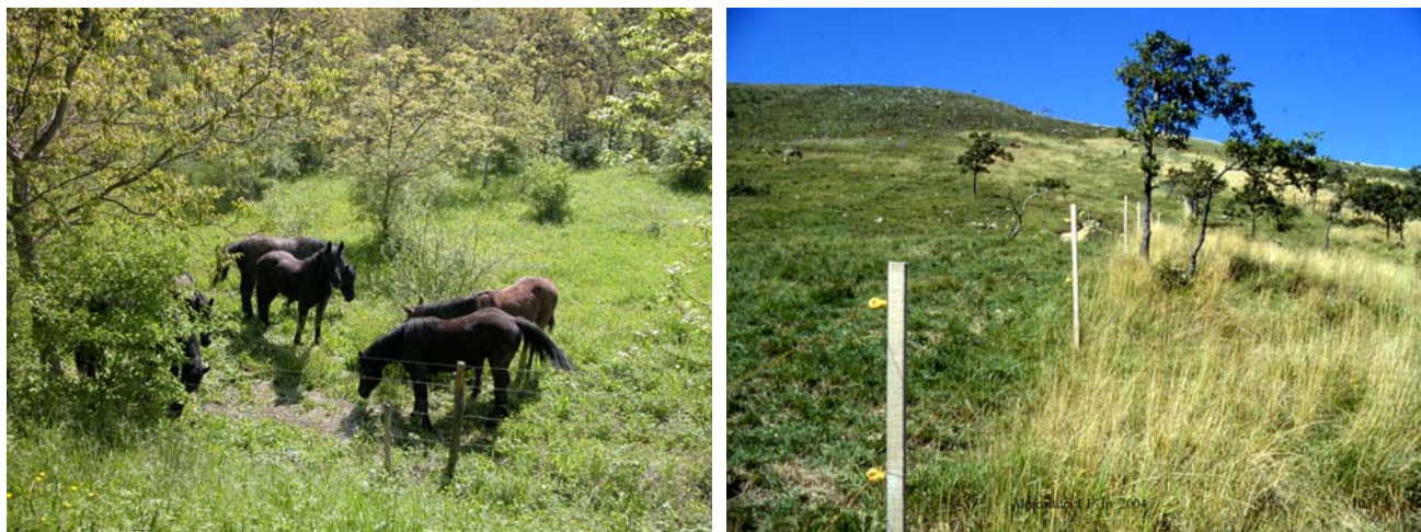
Figura 5. Esempi di recinzioni fisse: A) recinzione fissa a 4 fili in metallo con pali in legno per il contenimento di cavalli; B) recinzione fissa con pali in legno a 2 fili elettrificabili e abbattibili.
