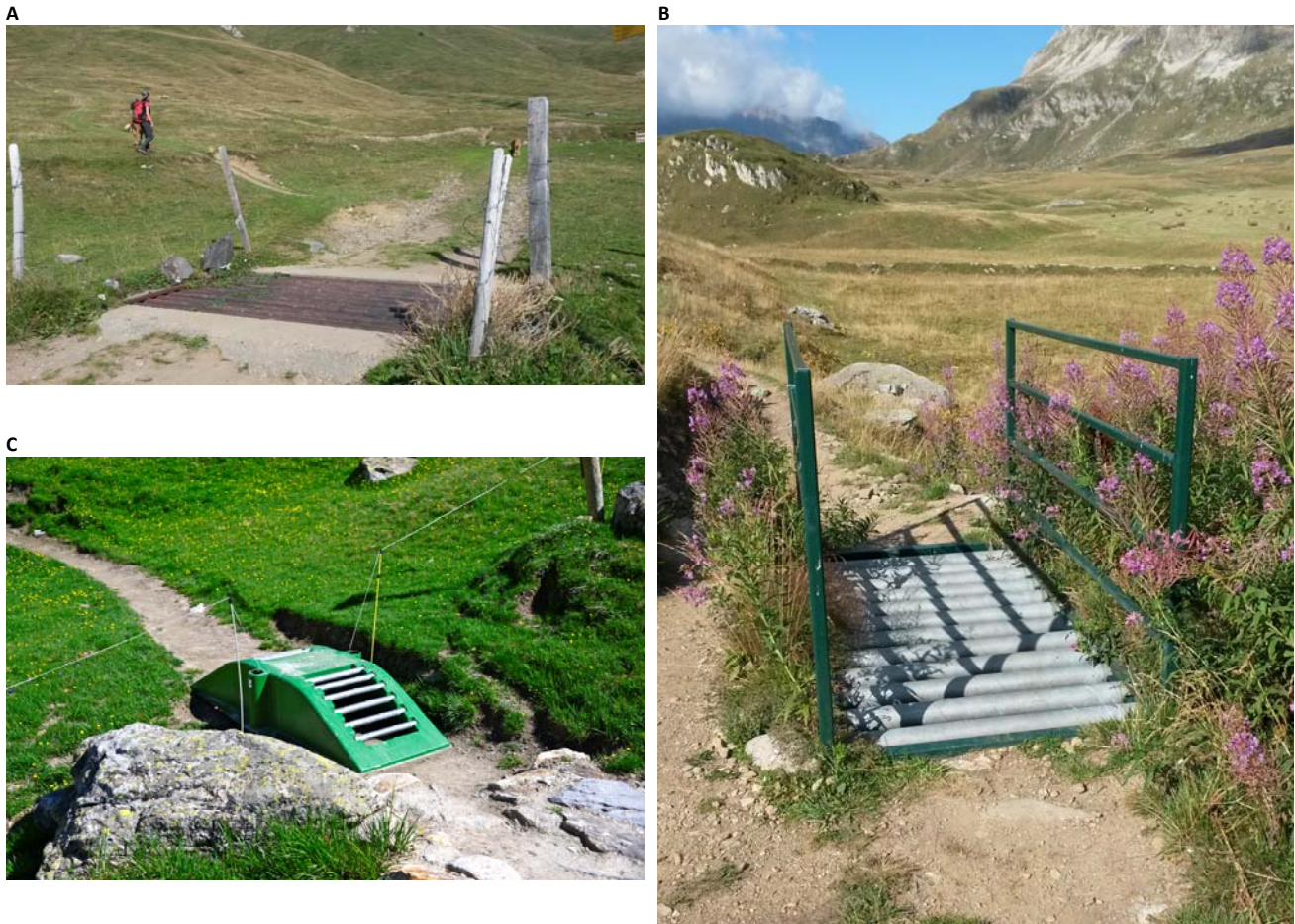
Figura 11. Esempi di cancelli canadesi su A) recinzione fissa e B)-C) recinzioni mobili elettrificate, adatti a percorsi escursionistici e cicloturistici. Questo tipo di cancelli è atto al contenimento sia di bovini, sia di ovini.
