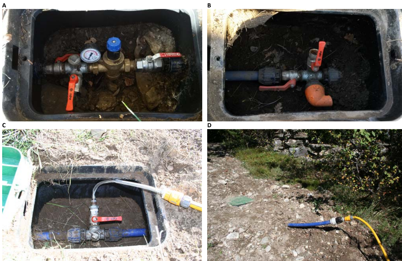
Figura 16. Esempio di raccordi in pozzetti di condotte interrato per l'adduzione di acqua per l'abbeverata come realizzati nel progetto LIFE Xero-grazing: A) misuratore di pressione, valvole di chiusura/apertura dell'acqua a monte e a valle e attacco per il collegamento di un tubo mobile di raccordo o lo scarico dell'impianto; B) sfiato, valvola di chiusura/apertura dell'acqua, attacco per il collegamento di un tubo di raccordo o lo scarico dell'impianto e sfiato; C)-D) sistemi di raccordo dei pozzetti alle tubazioni mobili di alimentazione degli abbeveratoi (cfr. Figura 18 ).
