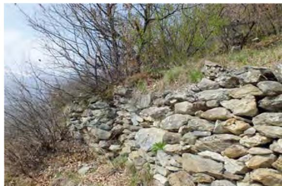
Particolare del muretto a secco di sostegno di un terrazzo (Mompantero).
